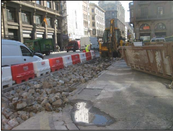
Imatge SE dels treballs de la obertura de la rasa 400
