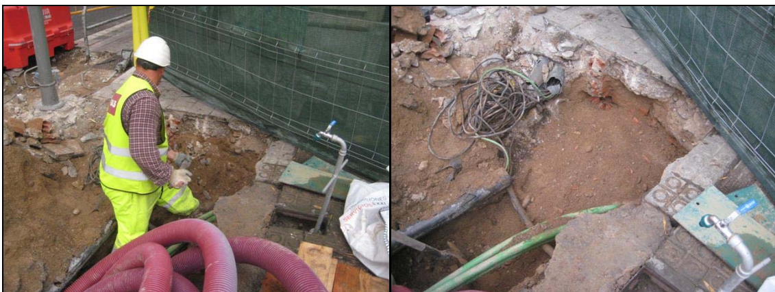
Vista dels treballs a la cala 500
