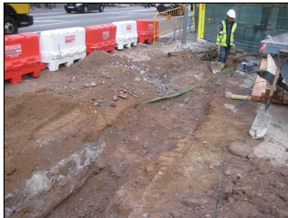
Imatge del formigó dels serveis del final de la rasa 400a
