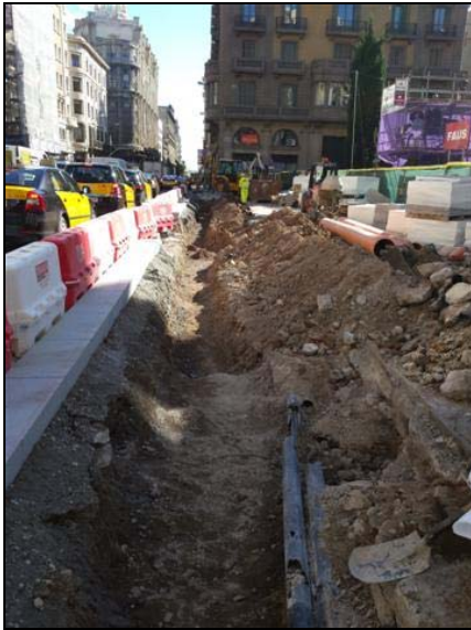
Vista general SE de la subrasa 400a un cop acabada
