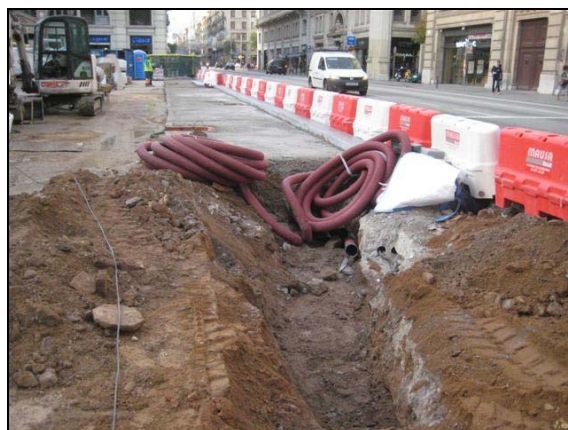
Vista general de la rasa 400 formigonada
