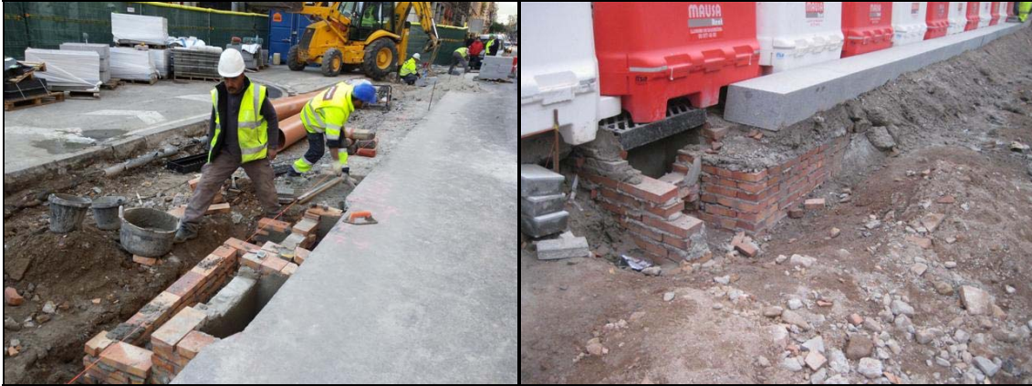
Vista dels treballs d'un dels embornals
