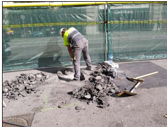
Treballs d'obertura de la cala 100
