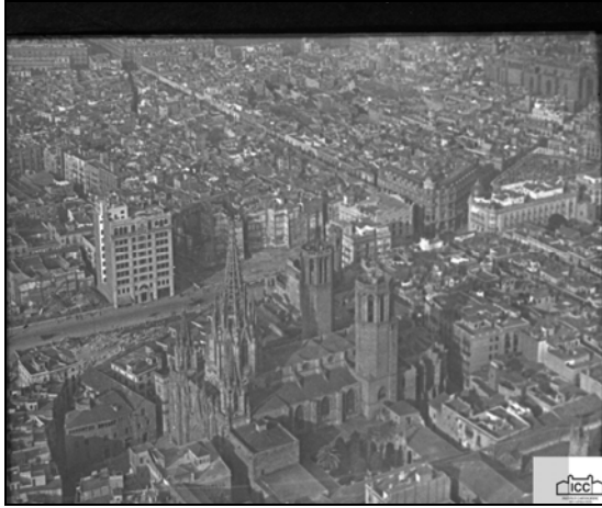
Vista de la Via Laietana en construcció. Es poden veure edificis d'aquest carrer ja enderrocats (ICC 1929)
