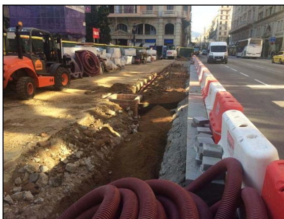
Vista general de la rasa 400 un cop colmatada amb el sauló
