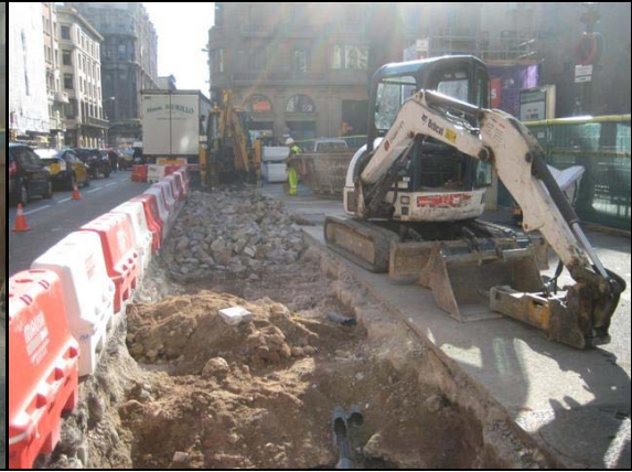
Imatge de la recollida dels paviments picats
