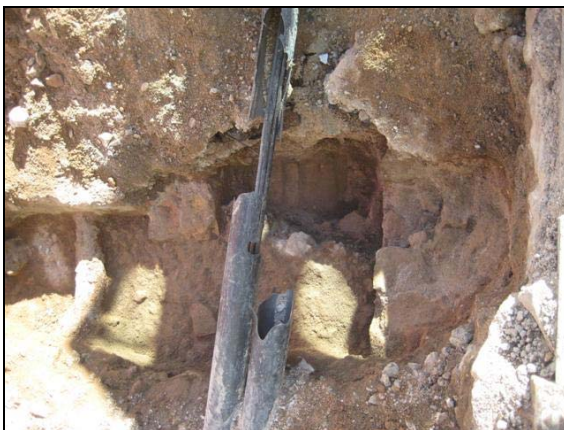
Vista SE dels serveis i estructures localitzades
